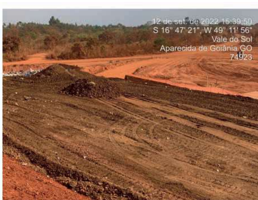
Figura 2: LETA utilizado como material de recobrimento.
