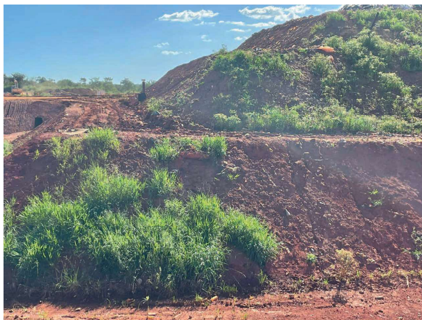
Figura 4: Talude com recobrimento de LETA apresentando o crescimento de gramíneas.
