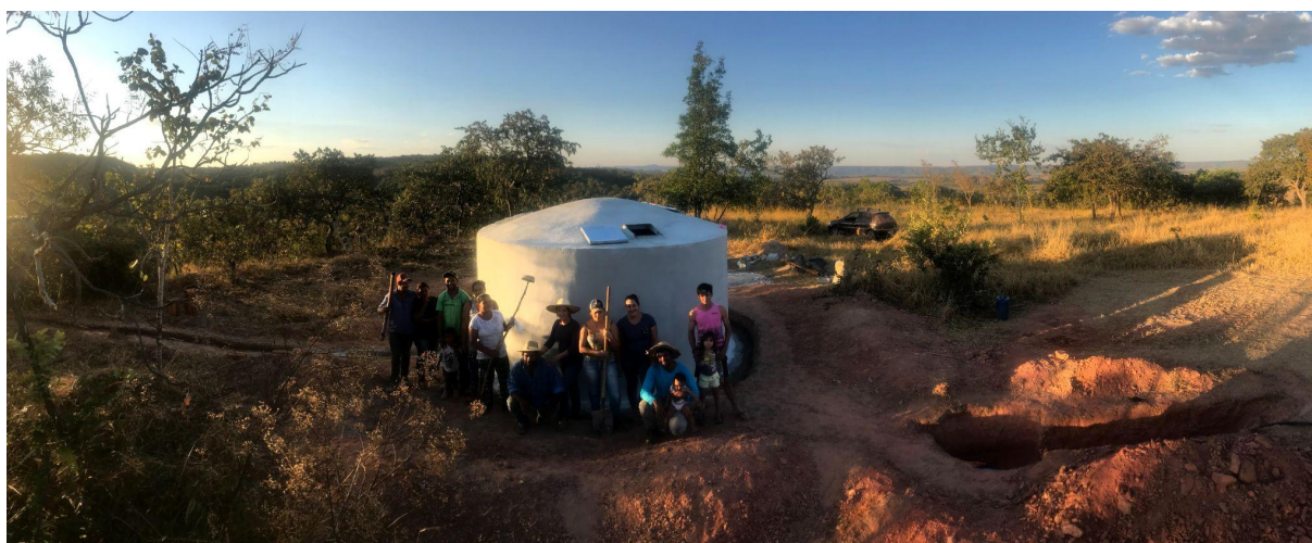
Mutirão de caixa d'água de ferrocimento em Caiapônia (2022); foram construídas 9 (nove) cisternas e/ou caixas d'água em ferrocimento, para captação de água das chuvas ou armazenamento de bombas solares, até Jun/2023
