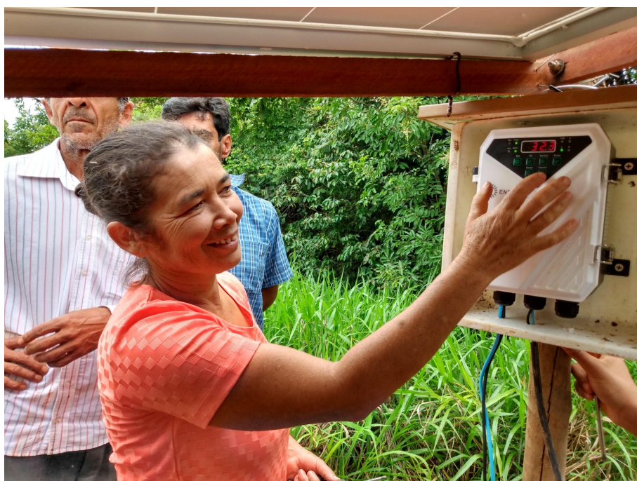
Agricultora liga a bomba solar para abastecimento da propriedade, em Orizona (2019)
