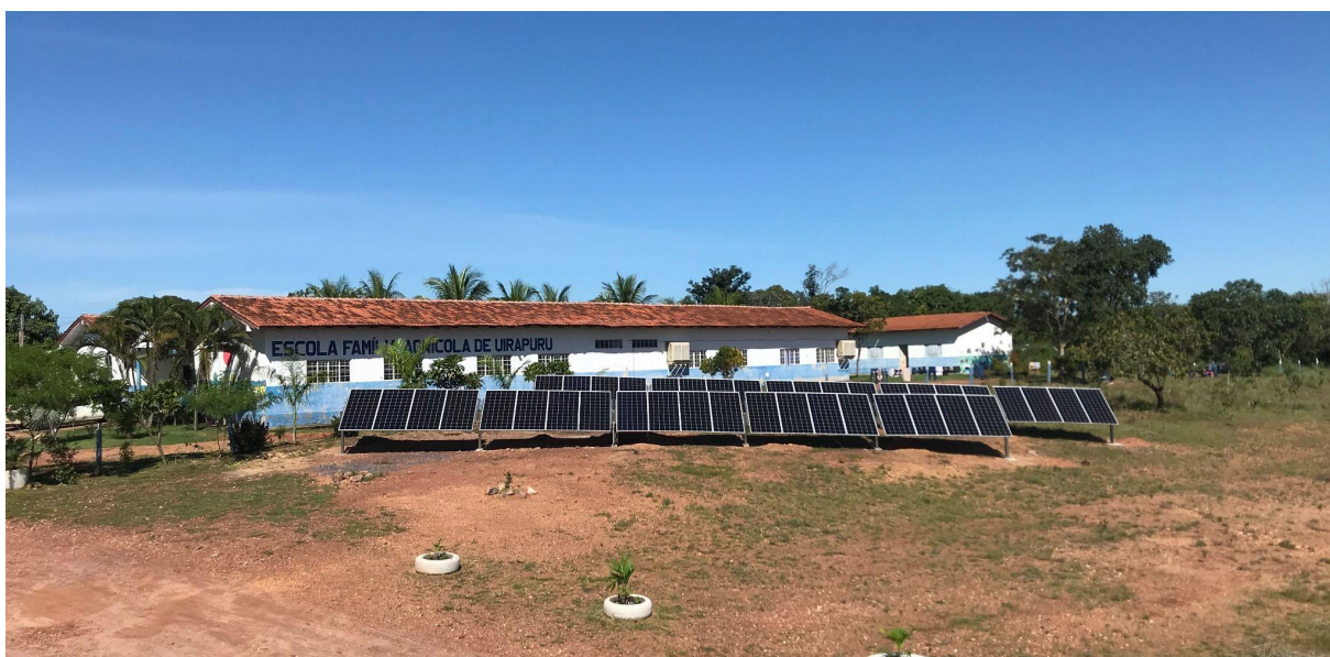
Sistema de energia solar instalado na Escola Família Agrícola de Uirapuru (EFAU), em Uirapuru (2020); foram instalados sistemas de energia solar nas 2 (três) Escolas Famílias Agrícolas do estado de Goiás, dos municípios de Goiás, Orizona e Uirapuru
