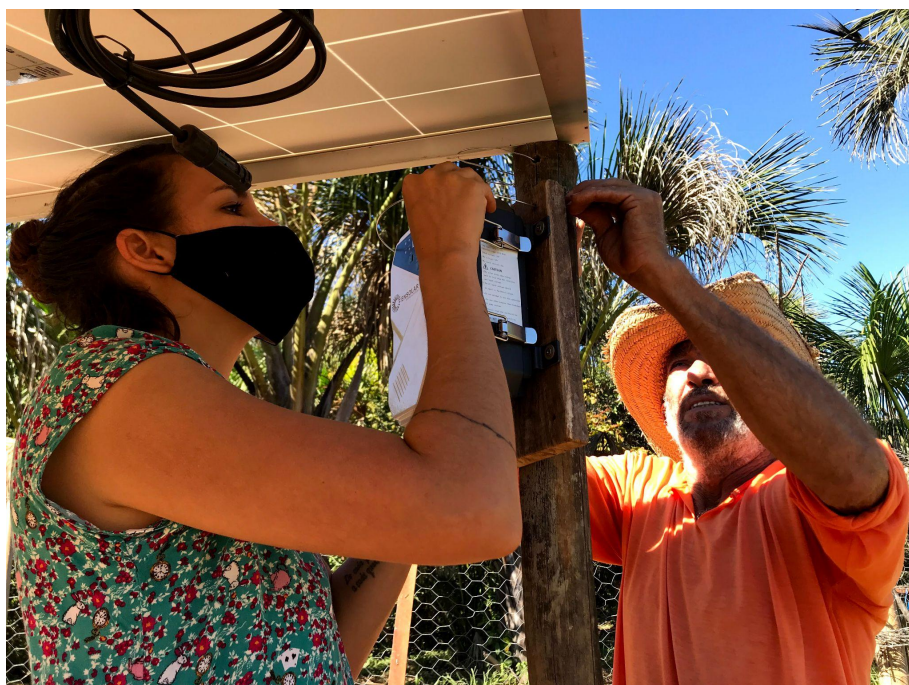
Técnica instaladora e agricultor instalando bomba solar em Bom Jardim de Goiás (2019)
