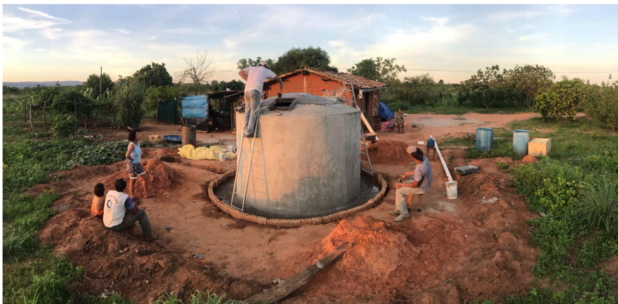
Construção de cisterna de captação de água de chuva no Assentamento Marco Lins, em Divinópolis de Goiás (2019)
