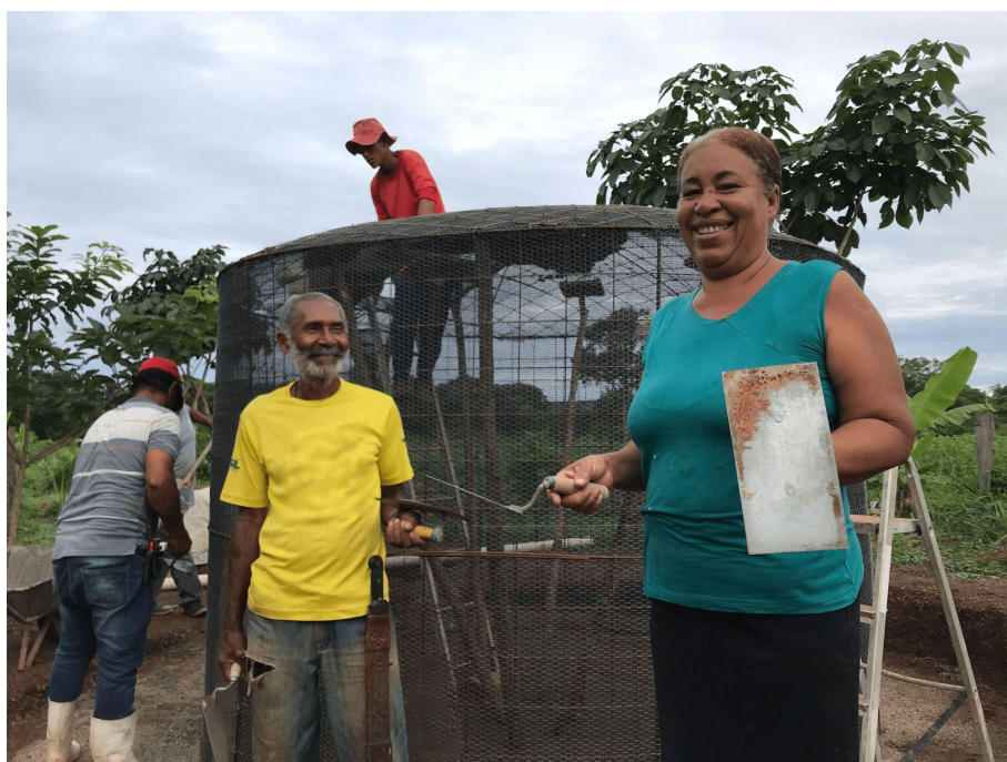
Construção de cisterna na Comunidade Vazante, em Divinópolis de Goiás (2022)
