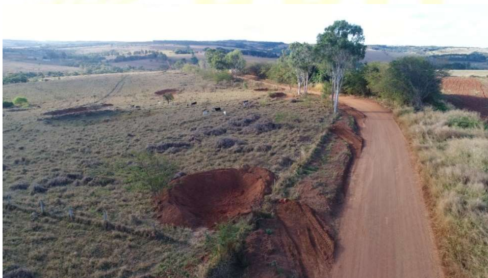
Figura 3: Barraginha implantada na região da bacia do Ribeirão Piancó em Anápolis.
