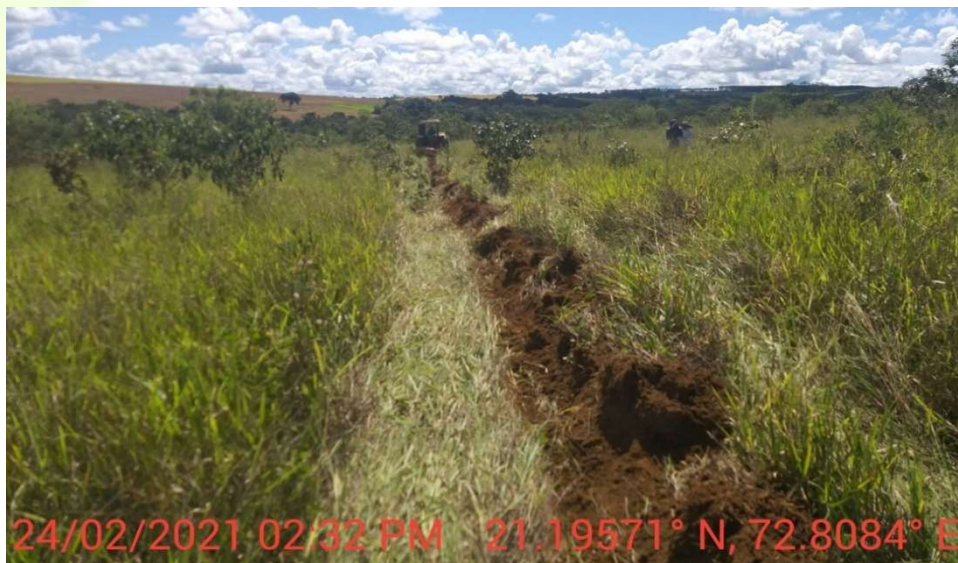
Figura 4. Construção de curva de nível para terraceamento na região da bacia do Ribeirão Piancó.
