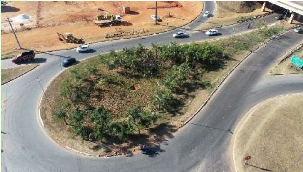
Figura 8: Jardim de Chuva na construído no trevo da Recanto do Sol (saída para BR414)
