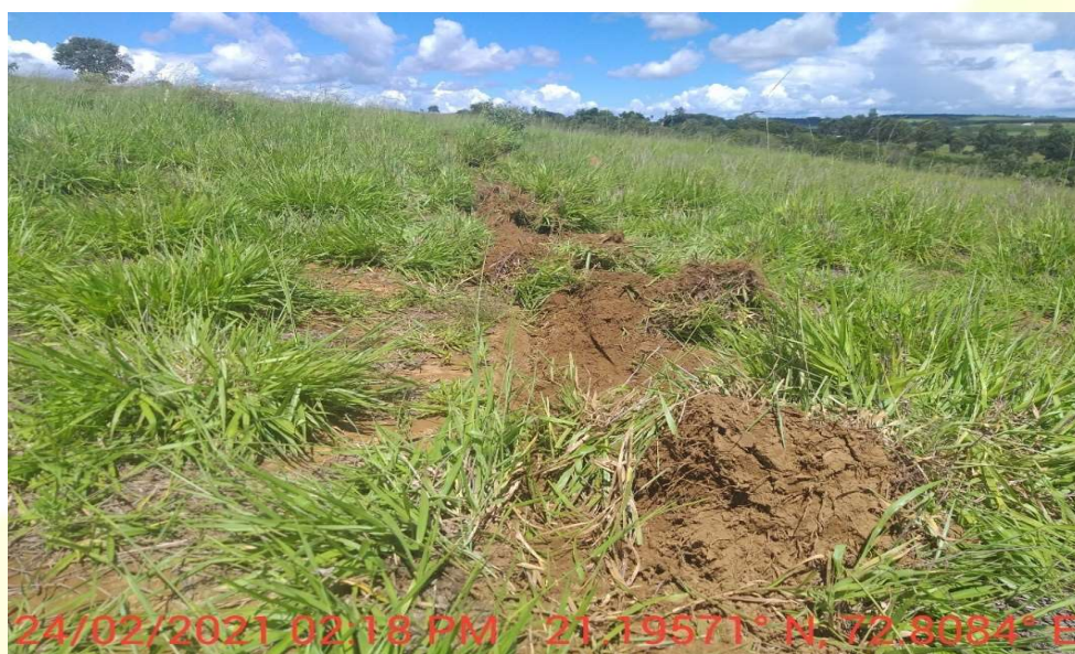
Figura 5. Construção de curva de nível para terraceamento na região da bacia do Ribeirão Piancó.
