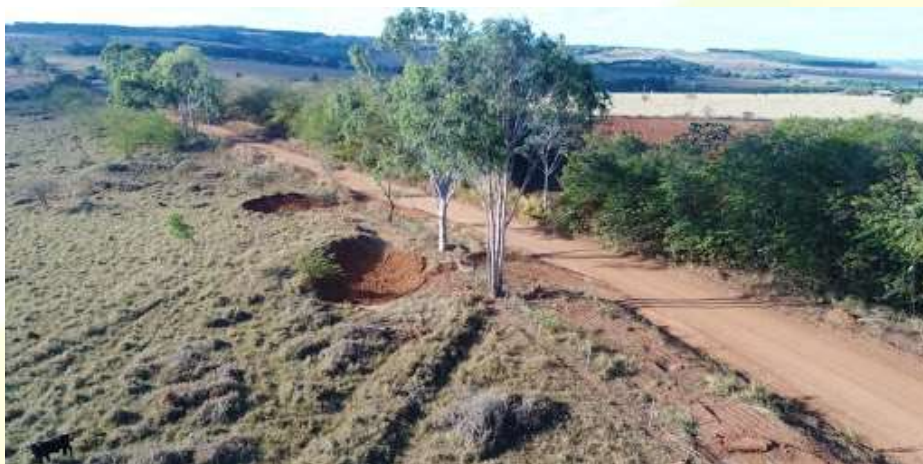
Figura 1: Barraginha implantada na região da bacia Ribeirão do Piancó em Anápolis.
