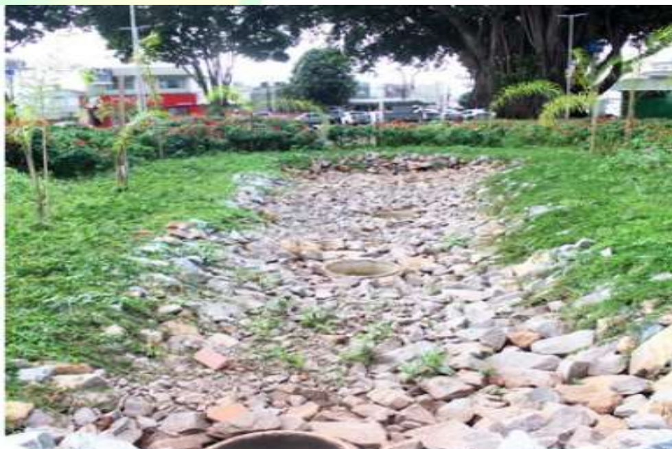
Figura 6: Jardim de Chuva construído na Praça Dom Emanuel. Fonte: Sítio do Pró-Água.
